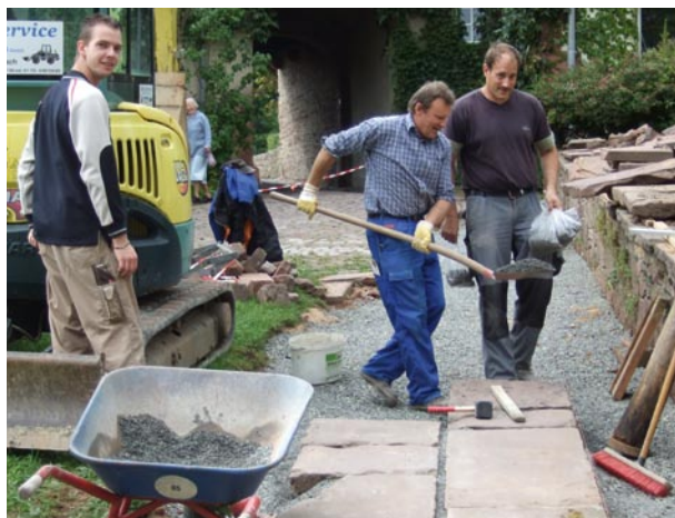
Ein neuer Weg auf Burg Rothenfels – auf unseren Baustellen wird hart gearbeitet. Im Bild drei Werkstätten mit typischer Handbewegung (v. r. n. l.): Alexander Harth, Erhard Roth und Zivi Manuel.
