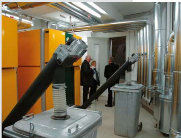
Alles blitzt: Brenner mit Aschebehältern
