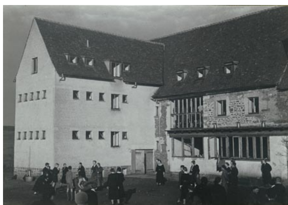
Die Zehntscheune wurde für den Arbeitsdienst hergerichtet, der von 1933 bis 1935 dort untergebracht war. Das Foto aus dem Jahr 1937 zeigt den Sanitärerbau und den zum Exerzierplatz aufgeschütteten Oberen Halsgraben (heute Parkplatz).
