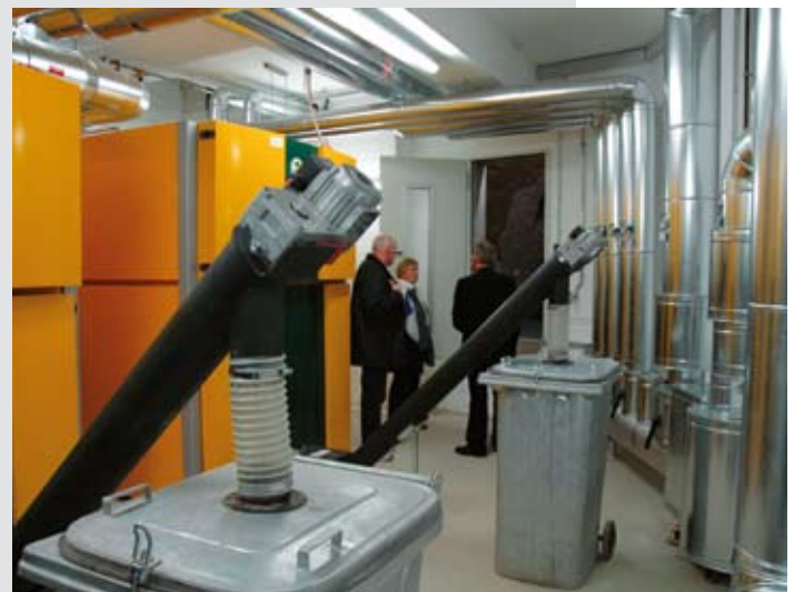
Alles blitzt: Brenner mit Aschebehältern
