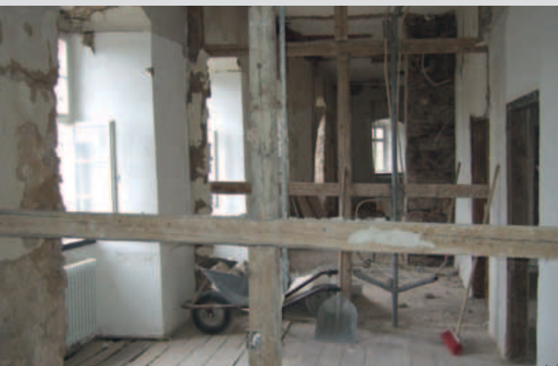
Einige Balken dürfen noch stehen bleiben ...
