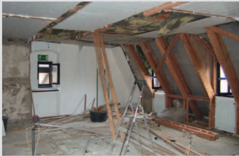
Verkleidung, Dämmung, Wände, ... alles muss raus!
