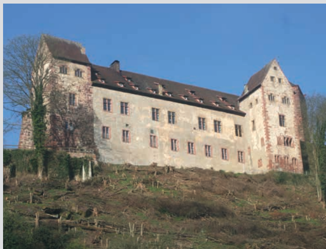
Burg Rothenfels, Ostflügel (Mainseite) mit Ostturm (rechts) und Südturm (links). Die Fassade ist großflächig mit neuzeitlichem Zementputz bedeckt (Foto: Günter Giessler, Rothenfels).
