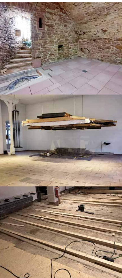
Oben: Neuer Bodenbelag im Gewölbesaal. Mitte: Schwebende Altarstufen und Leuchterhalterung ohne Leuchter. Unten: Zulaufende Balken für einen waagerechten Kapellenboden.
