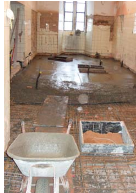
Ein neue Bodenplatte
