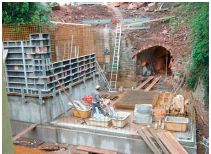
Baustelle 4: Bodenplatte und Verschalung
