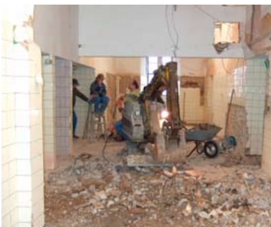
Der Abriss- bagger
