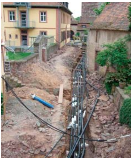
unten Baustelle 6: Der Heizraum wächst
