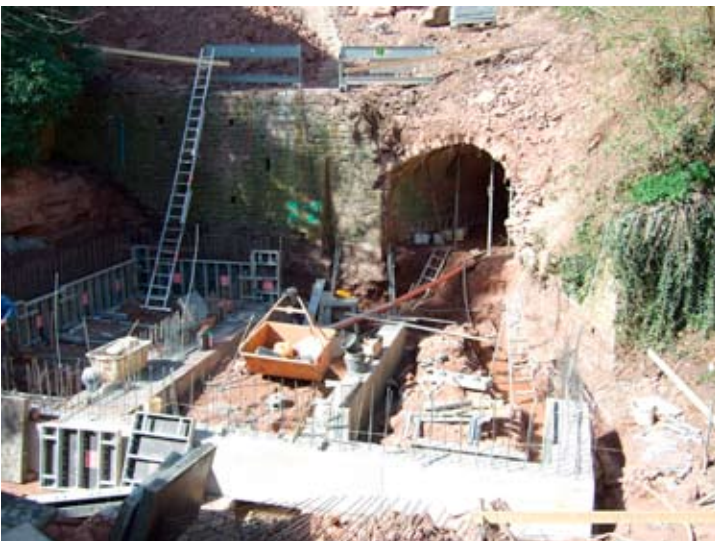
Baustelle 2: Die Fundamente
