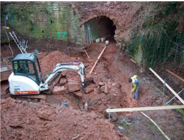
Baustelle 1: Im Schlamm
