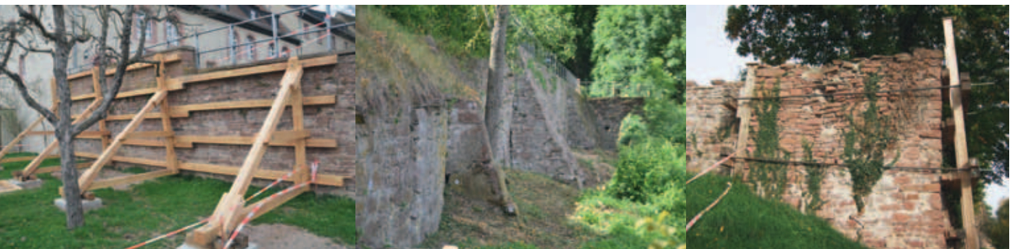
Die abgestützte Mauer am Spielplatz wird als erste saniert (Baubeginn 20. Oktober 2015). Mauer unterhalb des barocken Amtshauses. Der abgestützte Schalenturm am Grillplatz.
