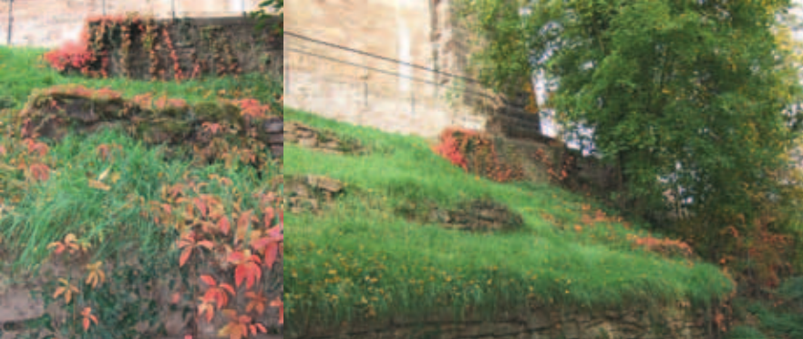
Mauern über Mauern: Terrassen am Südhang.
