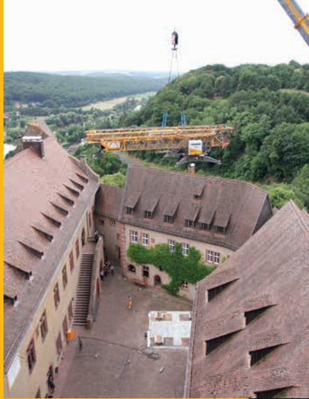
Rechts: Baustellenzufahrt über den unteren Parkplatz und Bolzplatz.
