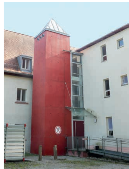
Der kleine Bruder des Bergfrieds – Aufzugsschacht an der Zehntscheune in Richtung oberer Parkplatz.
