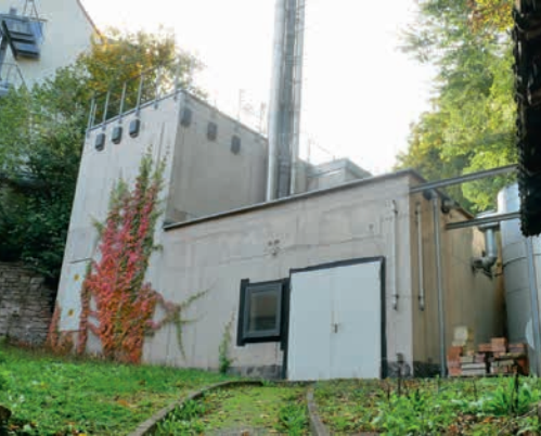
Hält die Gäste warm und sich selbst ungesehen: das burgeigene Wärmekraftwerk mit Holzhackschnitzelheizung.
