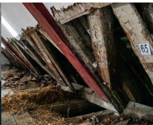
Links: Ganz nach Rudolf Schwarz: Auf das Wesentliche reduziert, schlicht und schön – Kemenate Zimmernummer 15. Rechts: Freigelegt und fein säuberlich dokumentiert – das Gebälk des Dachstuhls im Ostpalas.
