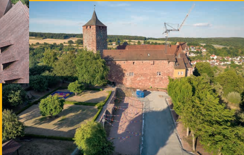
Links: Mithilfe eines Autokrans wurde der Baustellenkran in den Innenhof gehoben.
