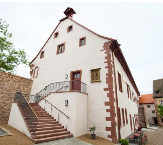
Der Ostpalas erstrahlt in neuem, „hellem“ Glanz. Blickfang ist die neue Kapellentreppe mit neuen Geländern und Beleuchtung.
